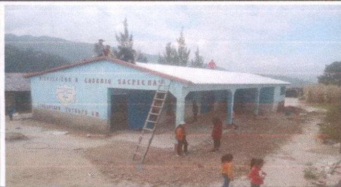
FOTO 1 Sustitución de lámina, por lámina troquelada aluzinc calibre 26, en el aula 1 y 2
